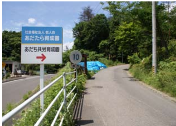
改装落成した障害者支援施設あだたら育成園の進入路。そこには除染作業で除去した汚染土が青いビニールシートをかけて保管されている。最終的には、国が設置する最終保管場所へ搬入されることになっているが、その時期は全く不明である。
